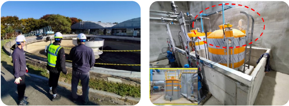
인천 만수 공공하수처리시설 증설현장 점검
